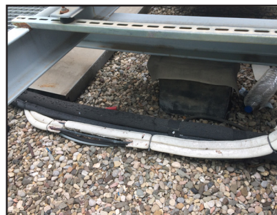
Aislamiento deteriorado, provocará sobreconsumos y reducción de vida útil.
