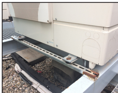
Aislamiento deteriorado, provocará sobreconsumos y reducción de vida útil.
