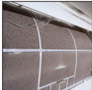
Los filtros sucios provocan sobreconsumos de ventiladores y reducción de vida útil.
